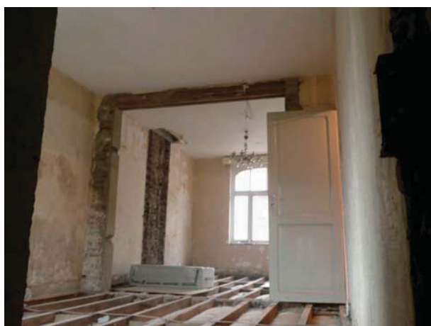
Intérieur avant travaux.
