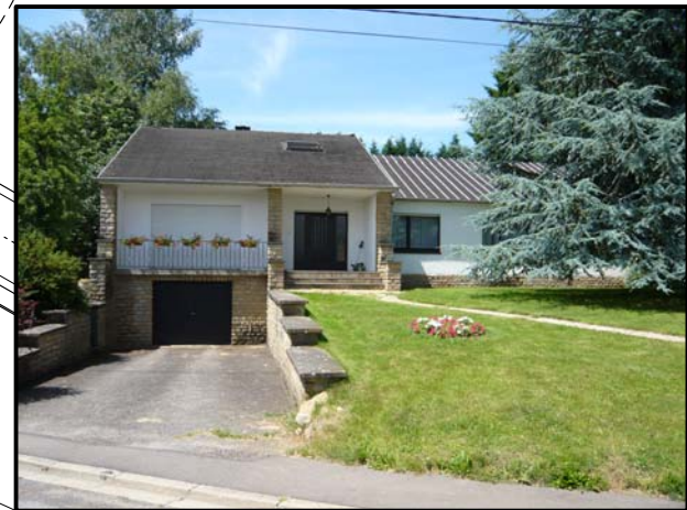
Habitation unifamiliale Couverture en ardoises artificielles teinte gris foncé Enduit de façade teinte blanche + pierre de France Baies à dominante horizontale
